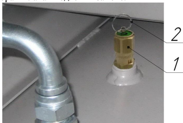
Рисунок 10 – Клапан предохранительный пружинного типа
